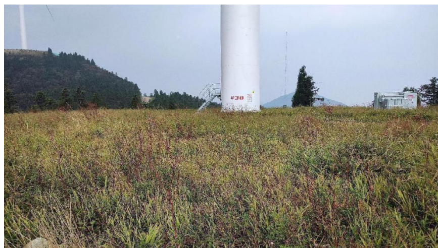
12#风机平台现状
