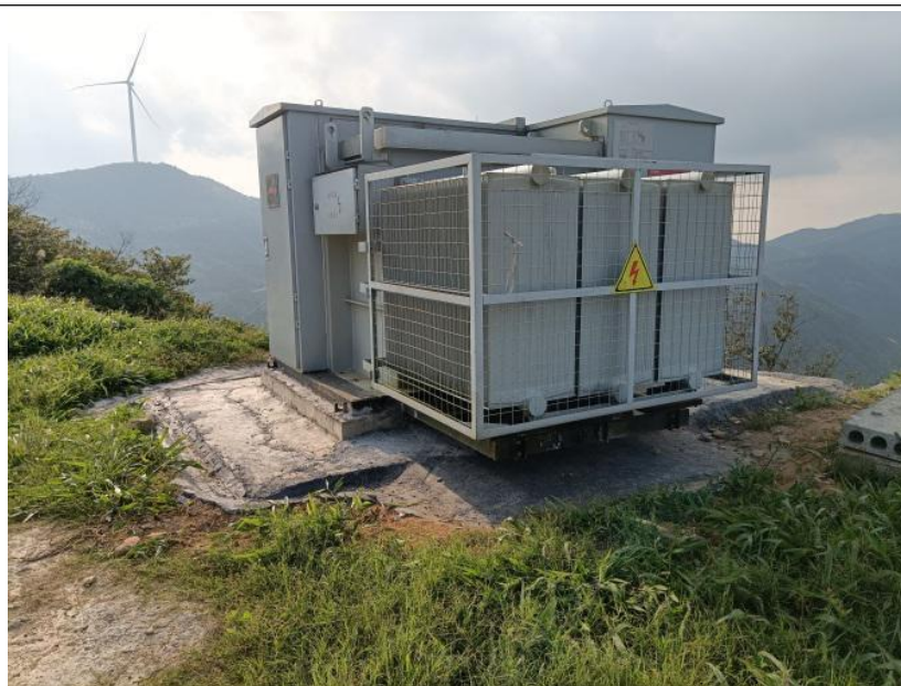
箱式变压器及基础
