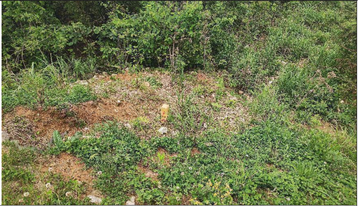
施工阶段 17#风机平台边坡金荞麦（移植）
