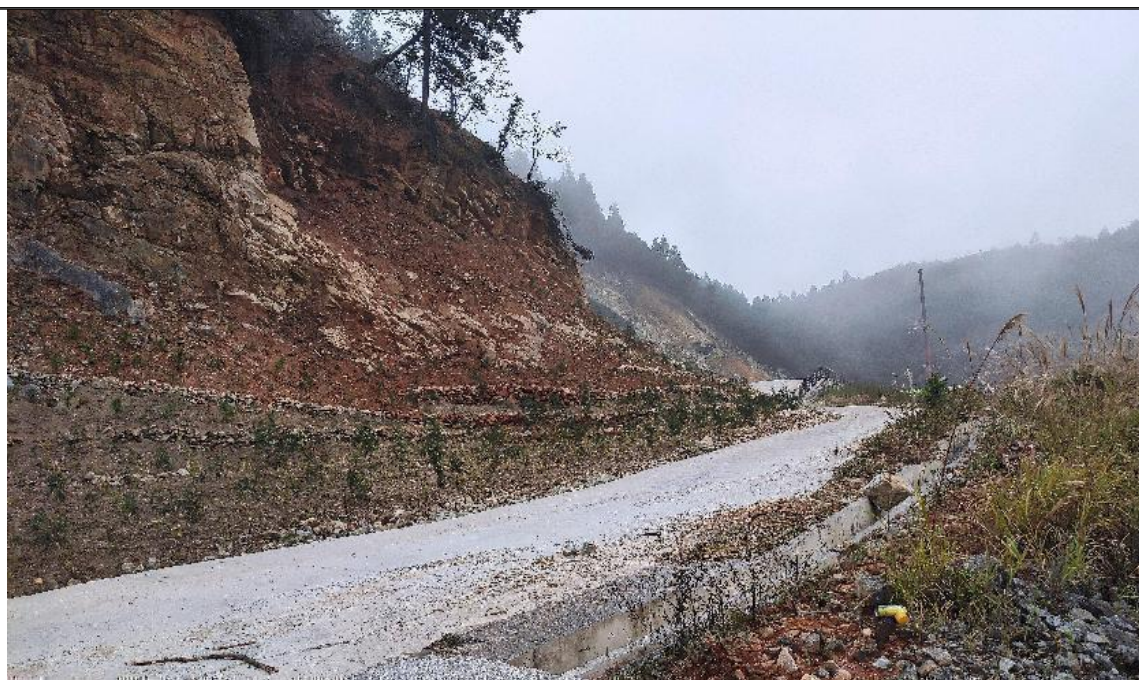
施工阶段 17#风机位西侧 200m 山坡（周边企业管理）
