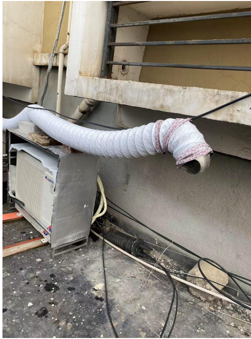
废气排口、空调室外机加装隔声罩
