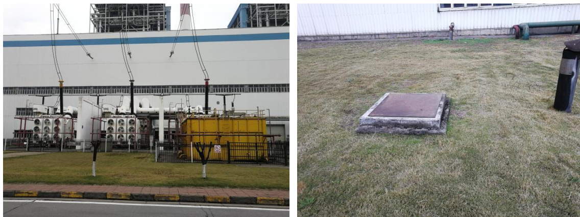
图3-1 主变压器下方卵石层及事故油池
