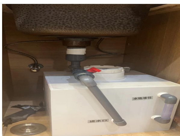
化验室中央处置台下方消毒装置
